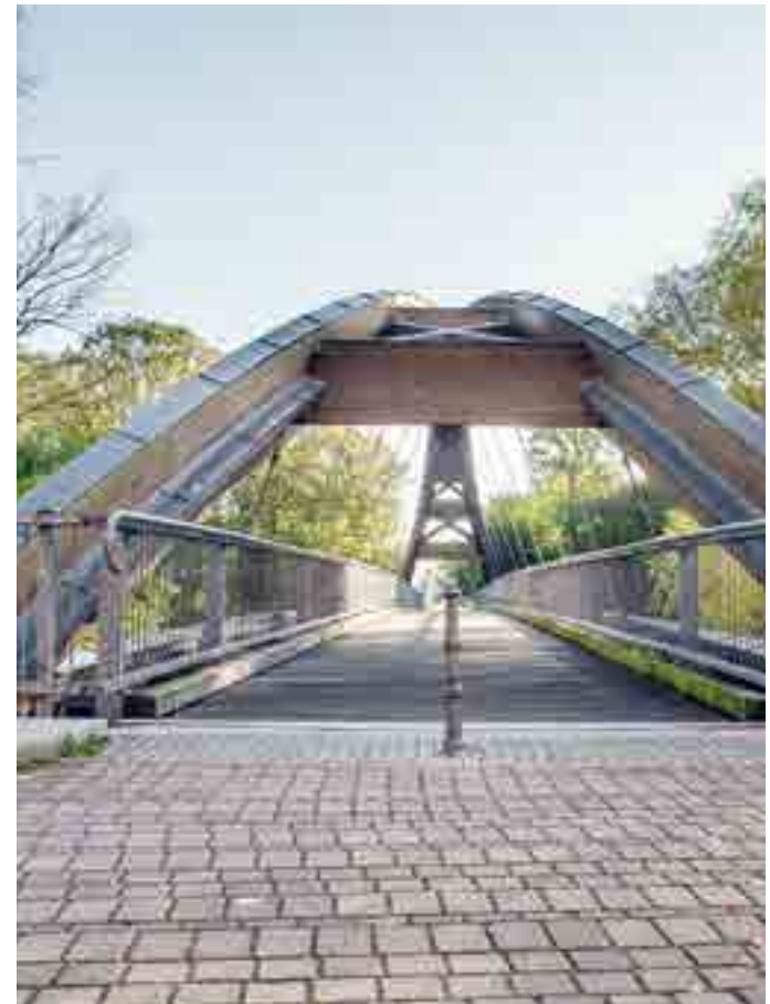
Brücke zur Insel Ziegenwerder
