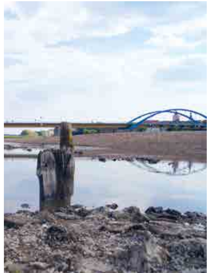
Reste der hölzernen Notbrücke
