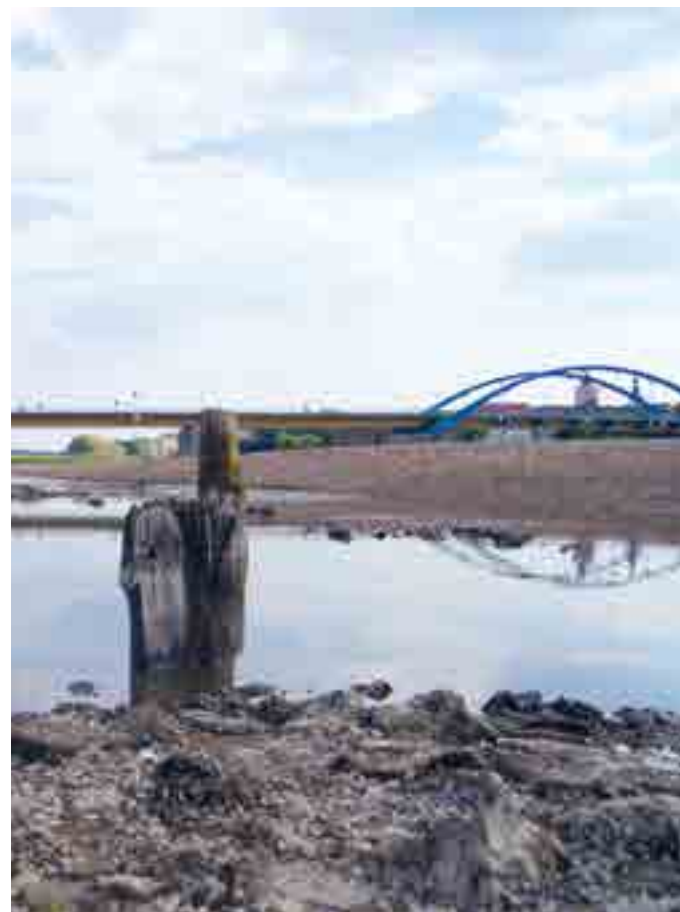
Pozostałości mostu drewnianego
